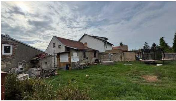
pohled na RD
