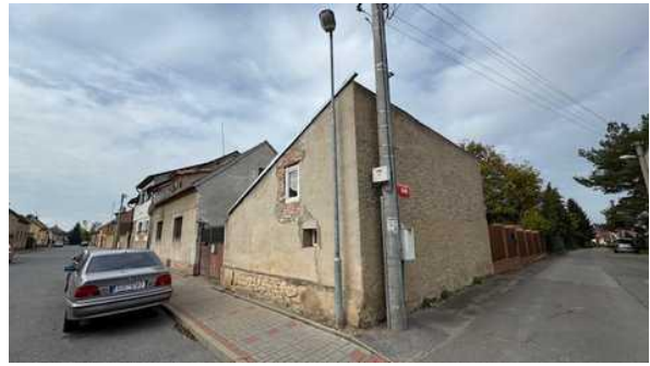
pohled na RD
