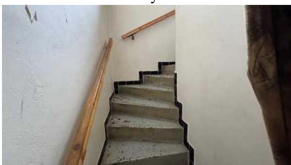
schodiště do podkroví
