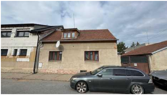
pohled na RD
