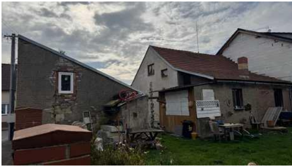
Pohled na RD
