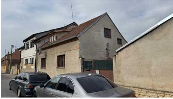
pohled na RD
